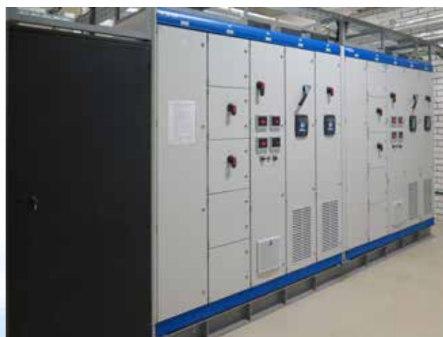
Комплетное устройство системы бесперебойного питания высоковольтных электроприводов
