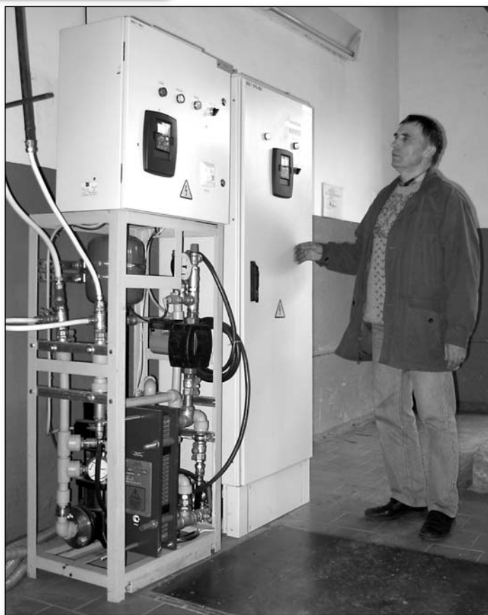
Рис. 5. Низковольтное комплектное устройство системы частотного регулирования на базе ПЧ с водяным охлаждением
