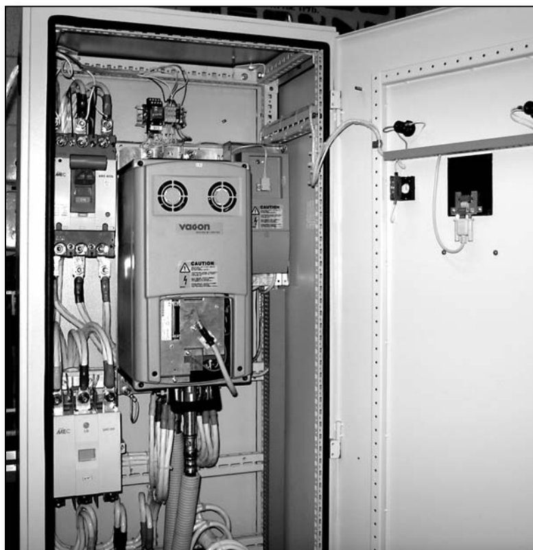
Рис. 4. Секция ПЧ с водяным охлаждением
