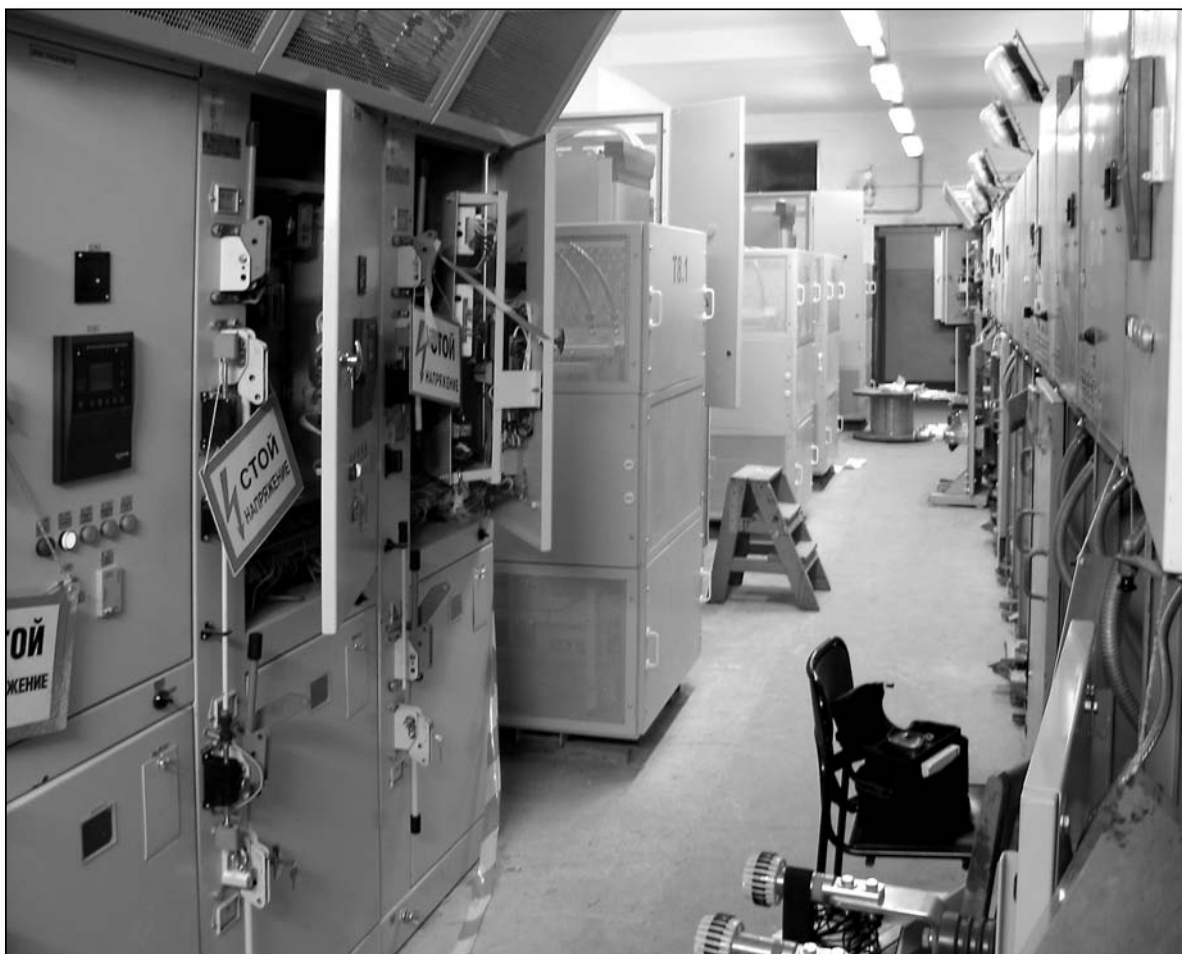
Рис. 5. Пример производства электромонтажных работ при установке оборудования СЧР
